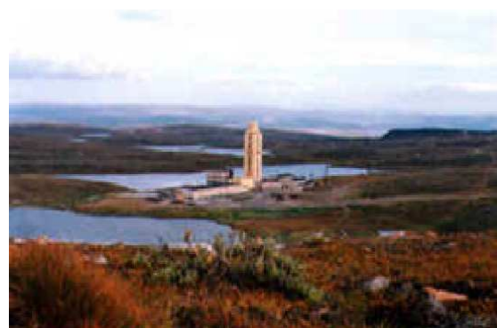
Figura 7: Torre de perfuração do poço SG-3 na Península de Kola.
