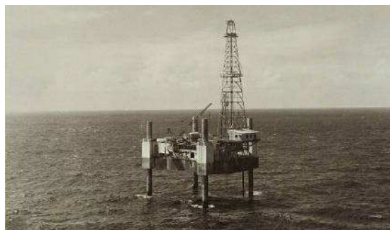
Plataforma de perfuração em Gauricema (SE).
